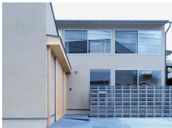
外観正面 前面道路より外観正面を見る。
