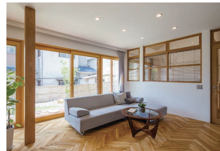
リビングから見渡す景色2 左の柱が一度切られていた部分、傾きを修整し新しい柱に取替えている。
