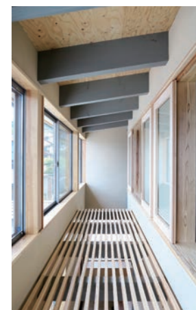
吹抜 夏季は窓を開け熱気を排出する。連続窓から日照を取り入れ格子を通して拡散し下階に送る。
