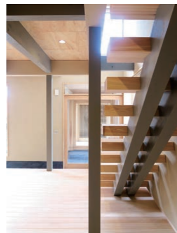
階段裏 力強くも軽快な造りの中桁階段は光や視線を通し、空間のアクセントにもなっている。
