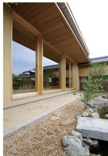
大開口外観 上部の大庇は夏の日差しの遮蔽と雨から木製建具を守る。
