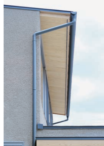
南面軒 南面に突き出した軒は年間を通して室内に入る日照を調整する。
