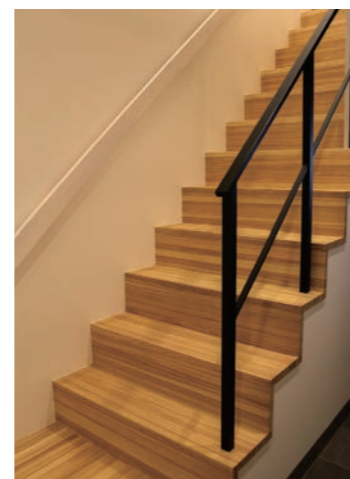
1回階段を見る。床材は県産材の杉柁目（浮作り）を採用した。
